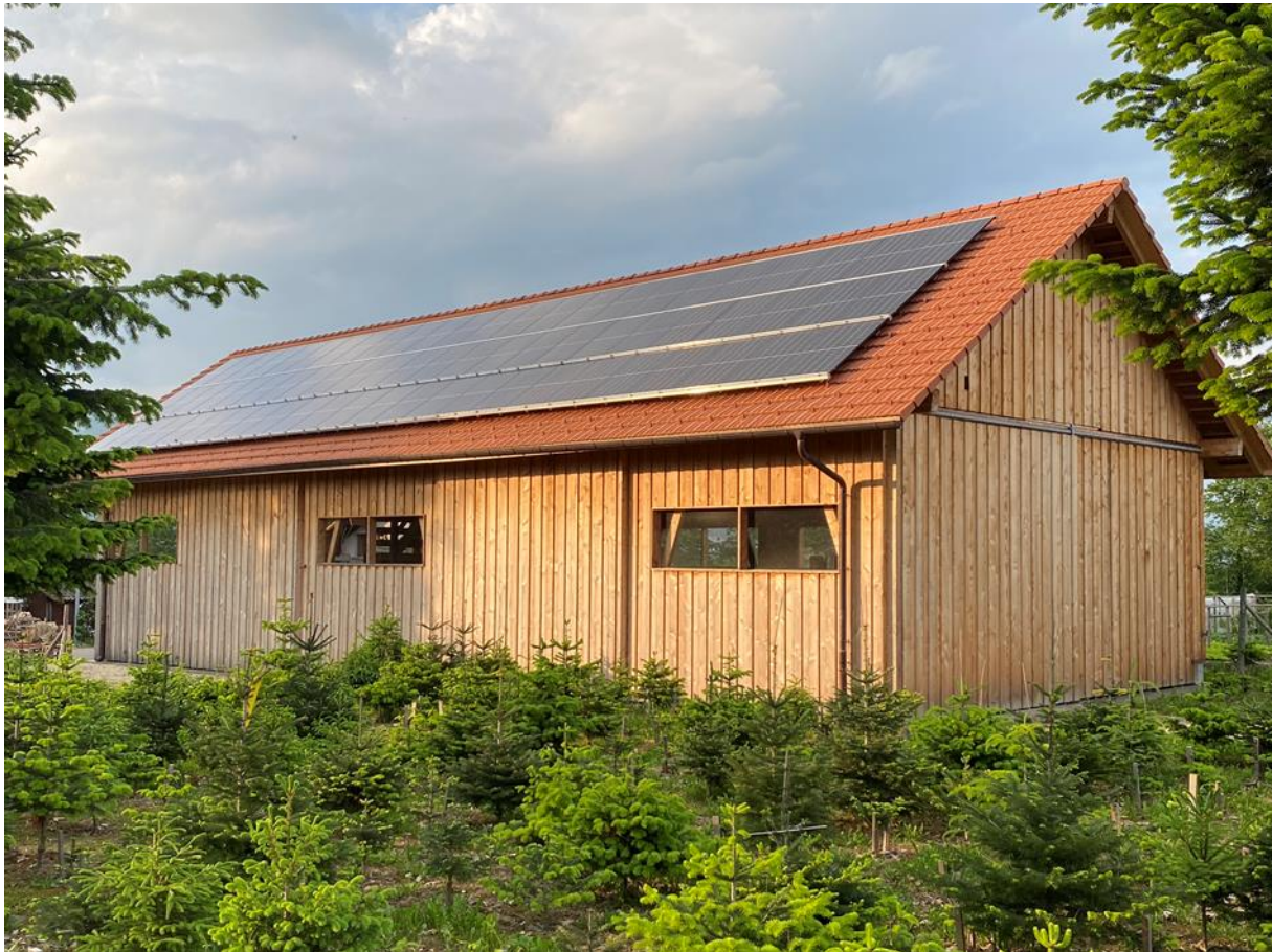
Solaranlage auf Halle der Wyss Weihnachtsbaumkulturen GmbH
